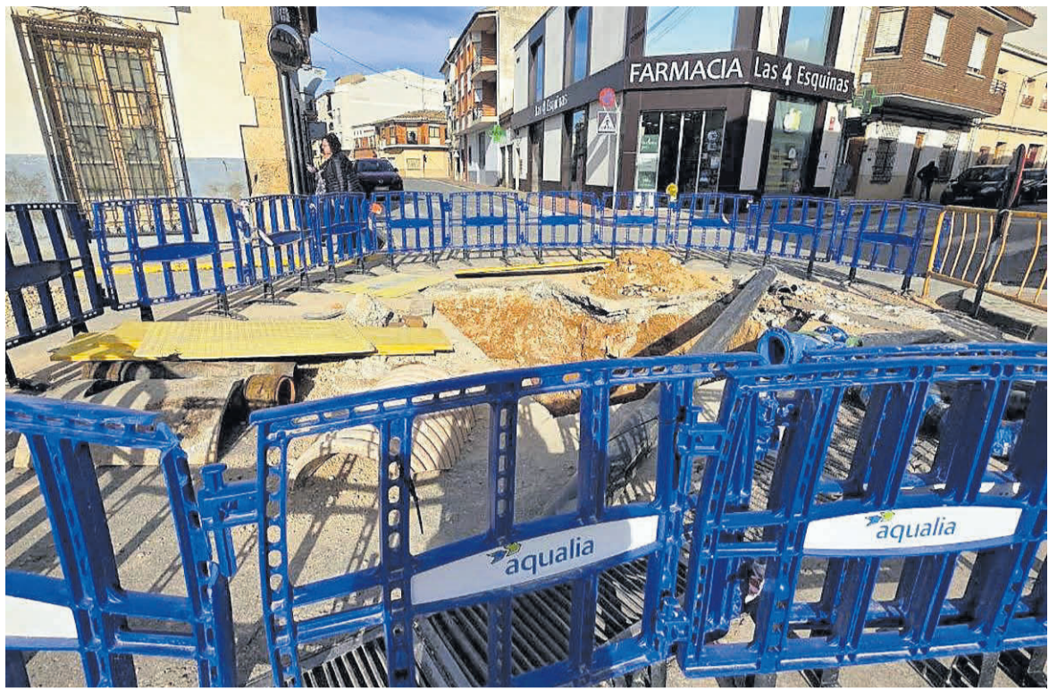
Aspecto que presentaba una de las calles del municipio, en pleno arreglo de la avería. / AYUNTAMIENTO LA RODA
